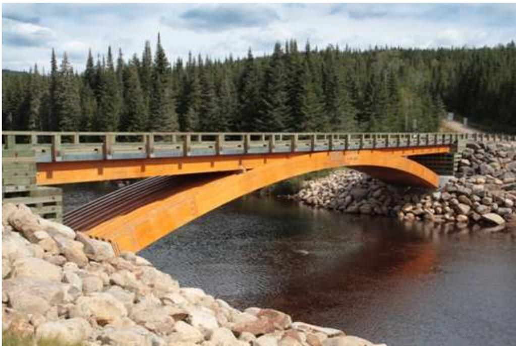
**Figura 1** - Ponte localizada na floresta de Montmorency para a travessia do rio Montmorency, Quebec, Canadá. Possui vão de 44 m, altura de 33 m e largura de 4,8 m [3].
